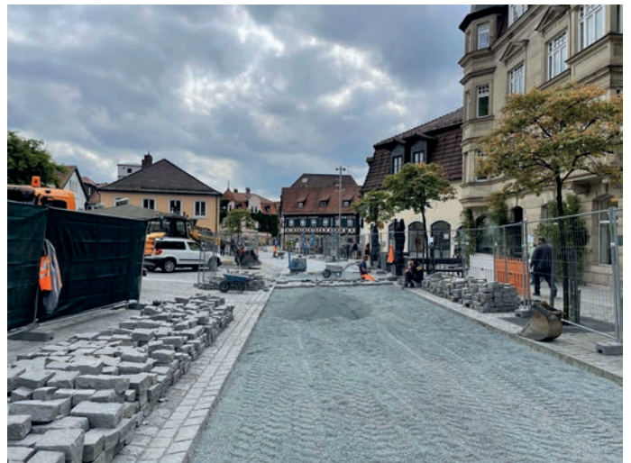
Die schrittweise Pflasterung des Marienplatzes
