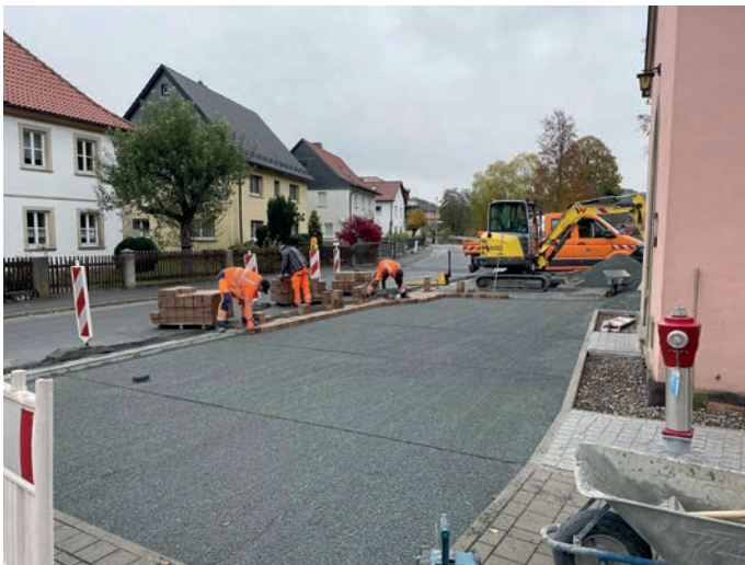
Die schrittweise Pflasterung des Marienplatzes
